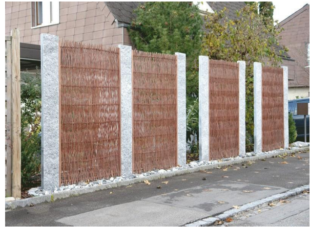
Weidenzaun Standard senkrecht eingebaut mit
