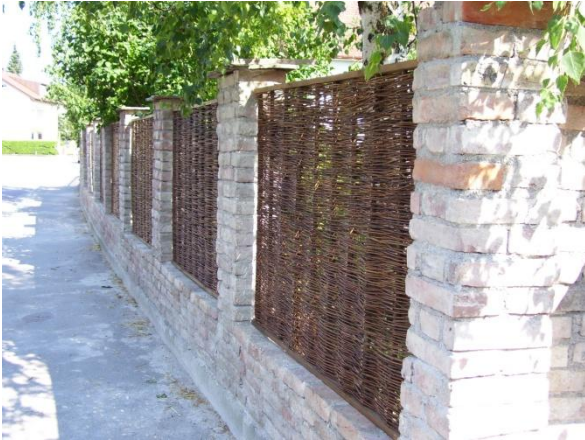
Weidenzaun Standard quer eingebaut mit gemauerten Pfosten aus Klinkern
